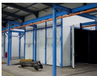
Окрасочно- сушильный комплекс
